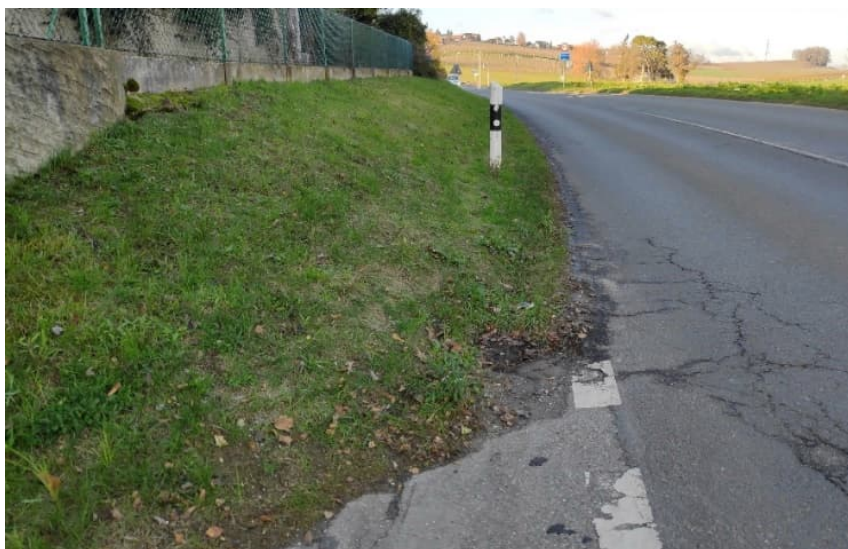
Talus empêchant la progression des piéton·nes vers les arrêts de bus « Gravelines »
