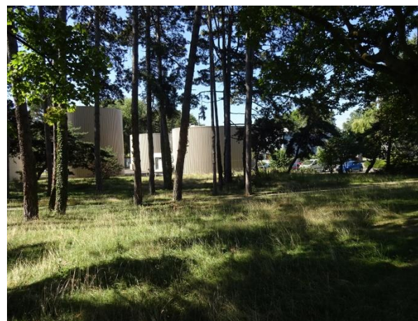
Vue depuis la route cantonale sur les digesteurs
